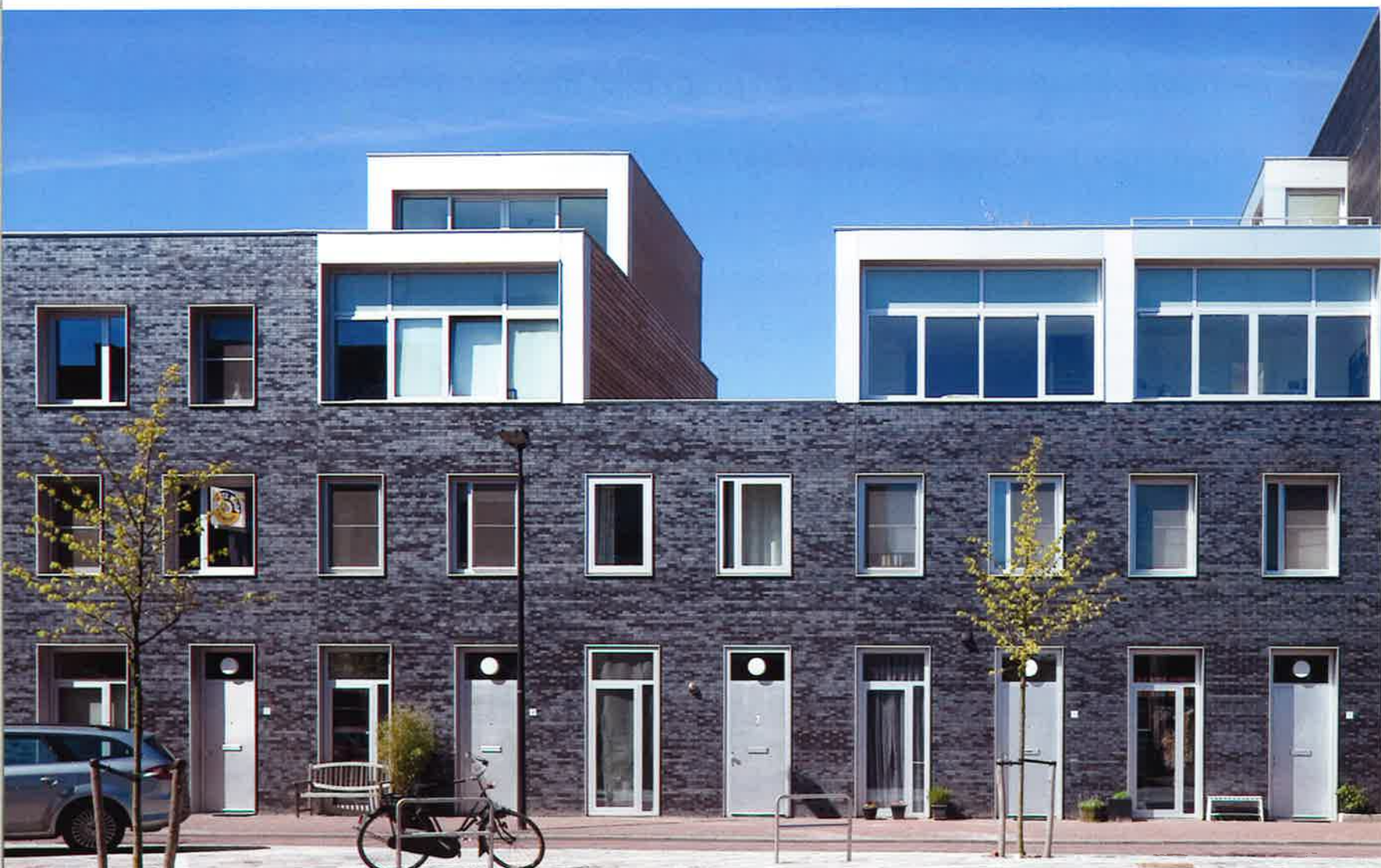
Multifunctioneel gebouw Multifunk, Amsterdam ANA Architecten
